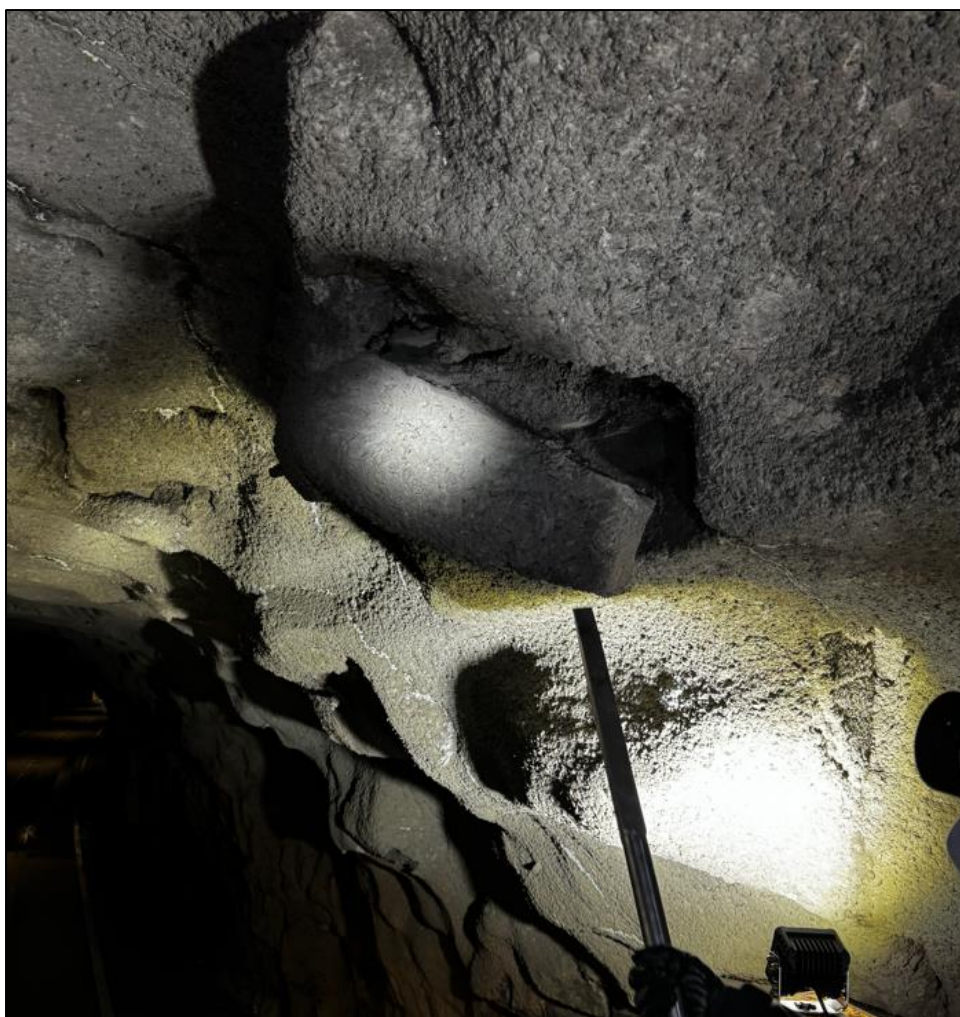
Foto 7. Pel 263 h. side: Mindre blokk som henger delvis i sprøytebetong. Det anbefales å prøve å renske den ned, evt. supplere med 1 stk 2,4 meter bolt.
