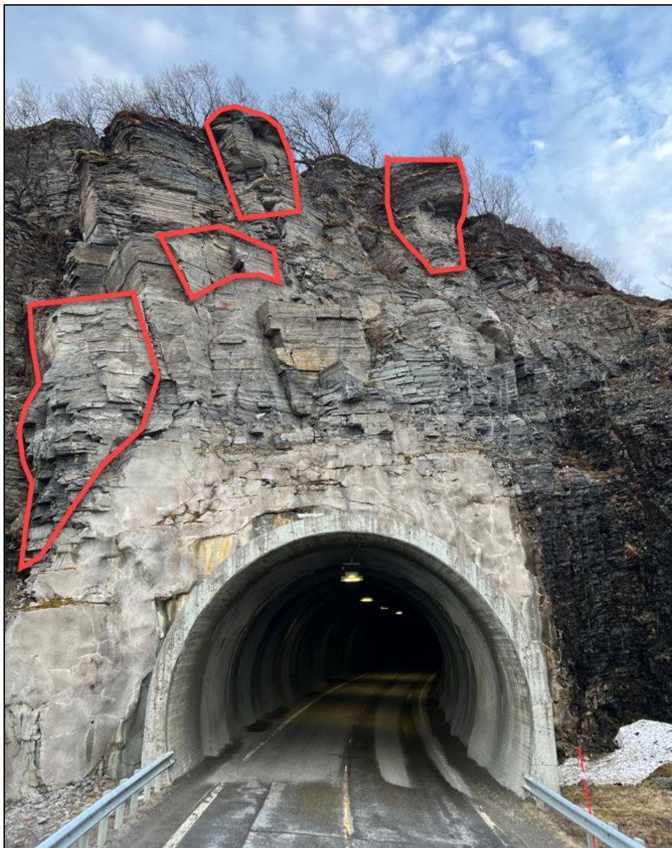
Foto 1. Oversikt forskjæring nordøst. Det er tidligere satt noen få bolter i overkant av tunnelåpningen. Berget er relativt tett oppsprukket og det vurderes dermed at det er nødvendig med spesialinspeksjon fra lift for å få en bedre oversikt over berget og utbredelse av sprekker. Fra bakkenivå er det observert bergpartier med tilsynelatende avgrensende sprekker i bakkant som burde boltesikres (se røde områder). Antall og lengde på boltene må vurderes nærmere ved spesialinspeksjon fra lift.
