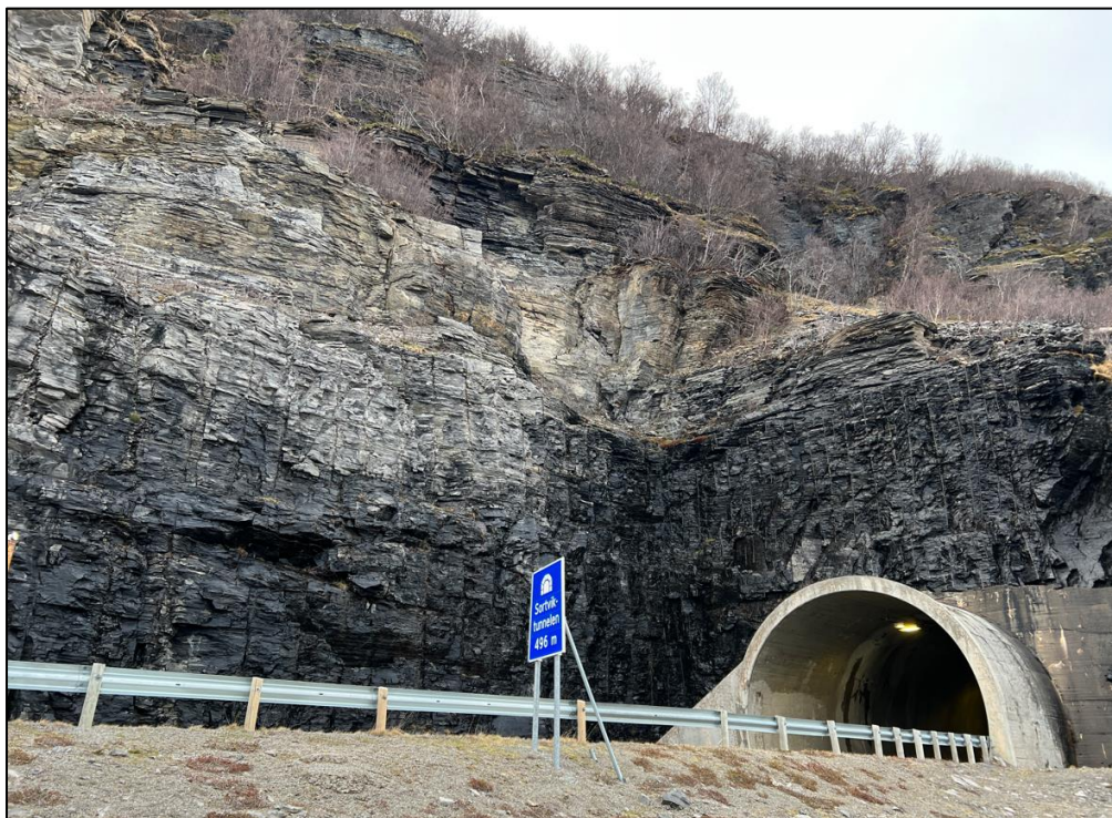
Foto 3. Oversikt over forskjæring sørvest. Venstre forskjæringsvegg er relativt høy med tett oppsprukket berg. Det anbefales spesialinspeksjon fra lift for å få bedre oversikt over sprekker i berget. Det anbefales også en vurdering av skredfare i naturlig terreng i overkant av venstre forskjæringsvegg.
