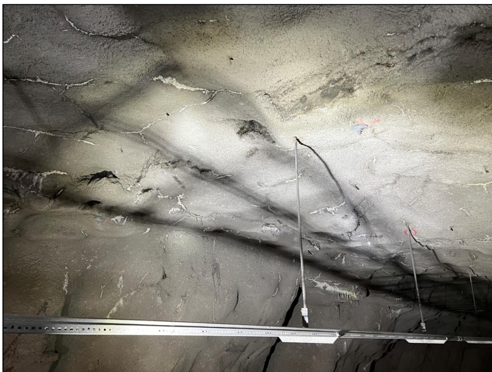
Foto 5. Eksempel på område med sprøytebetong med riss og kalkutfelling.
